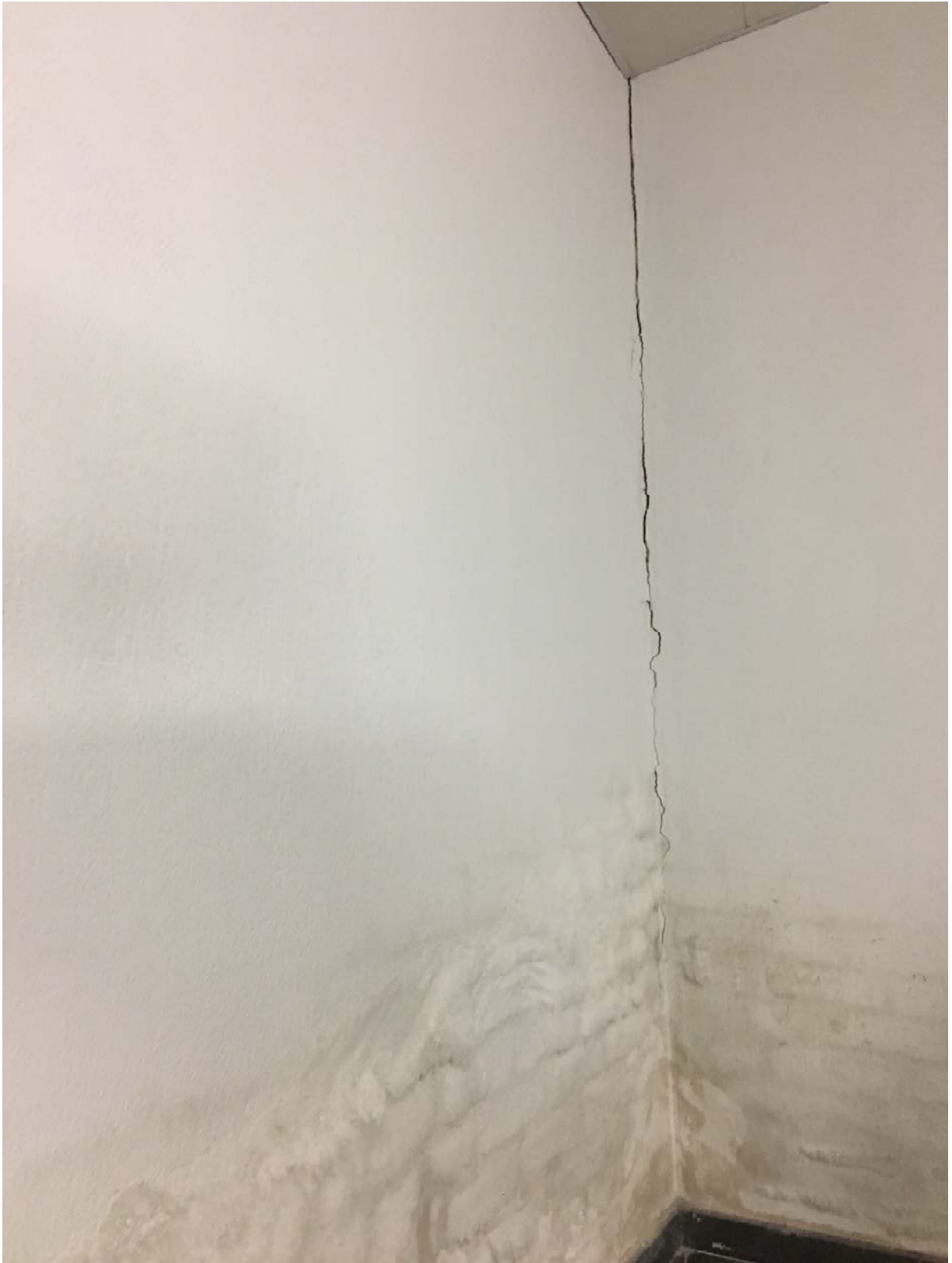
ZONA 3_4 – CUARTO ALMACENAJE.
