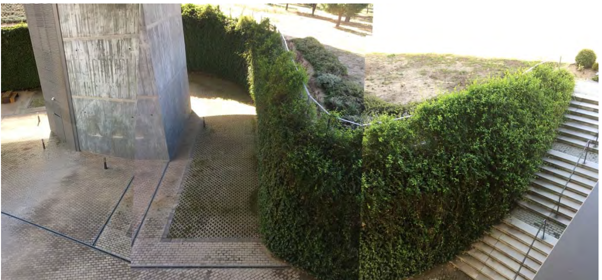
VISTA DE MURO VERDE DE PATIO EN NIVEL DE SOTANO 2.
