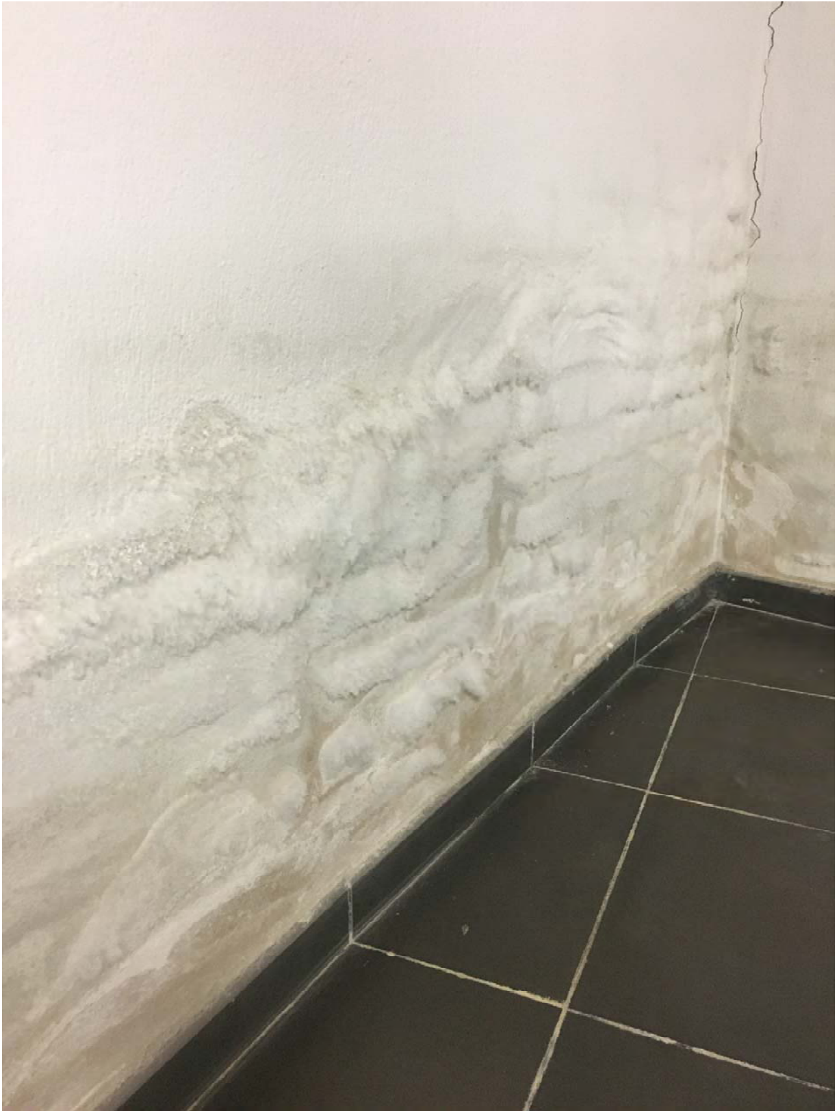
ZONA 3_3 – CUARTO ALMACENAJE.
