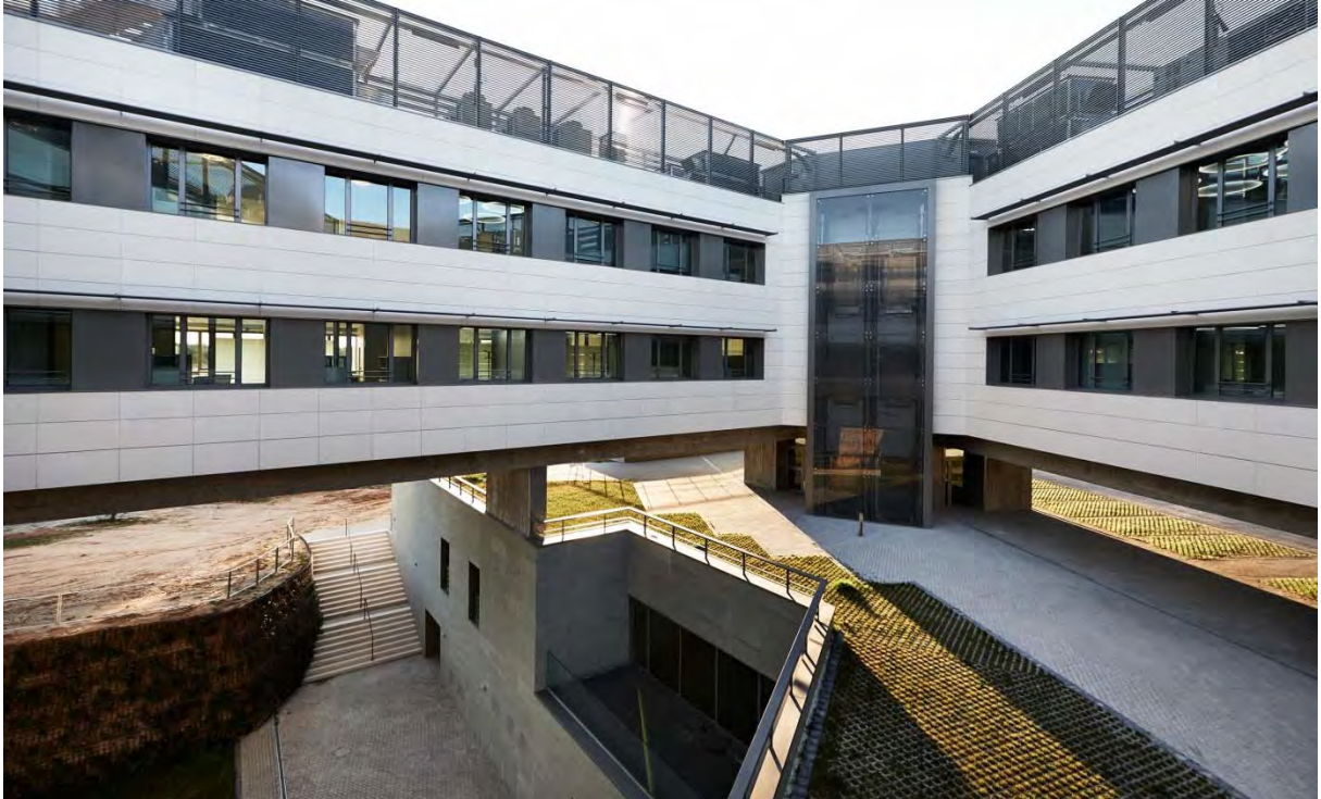
VISTA FACHADA INTERIOR PLANTAS 1,2 Y 3, FOSO DE PATIO Y NIVEL ACCESO.
