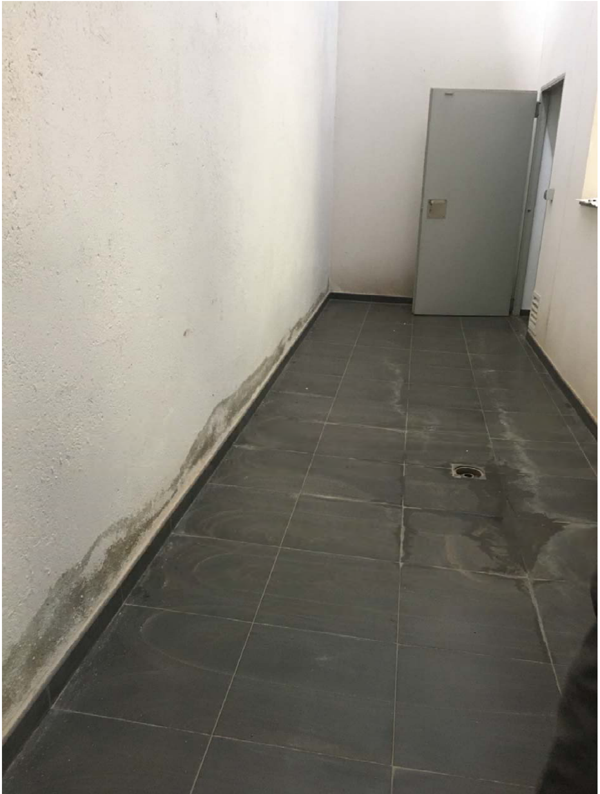
ZONA 6_2 – PATIO COCINA E INSTALACIONES.
