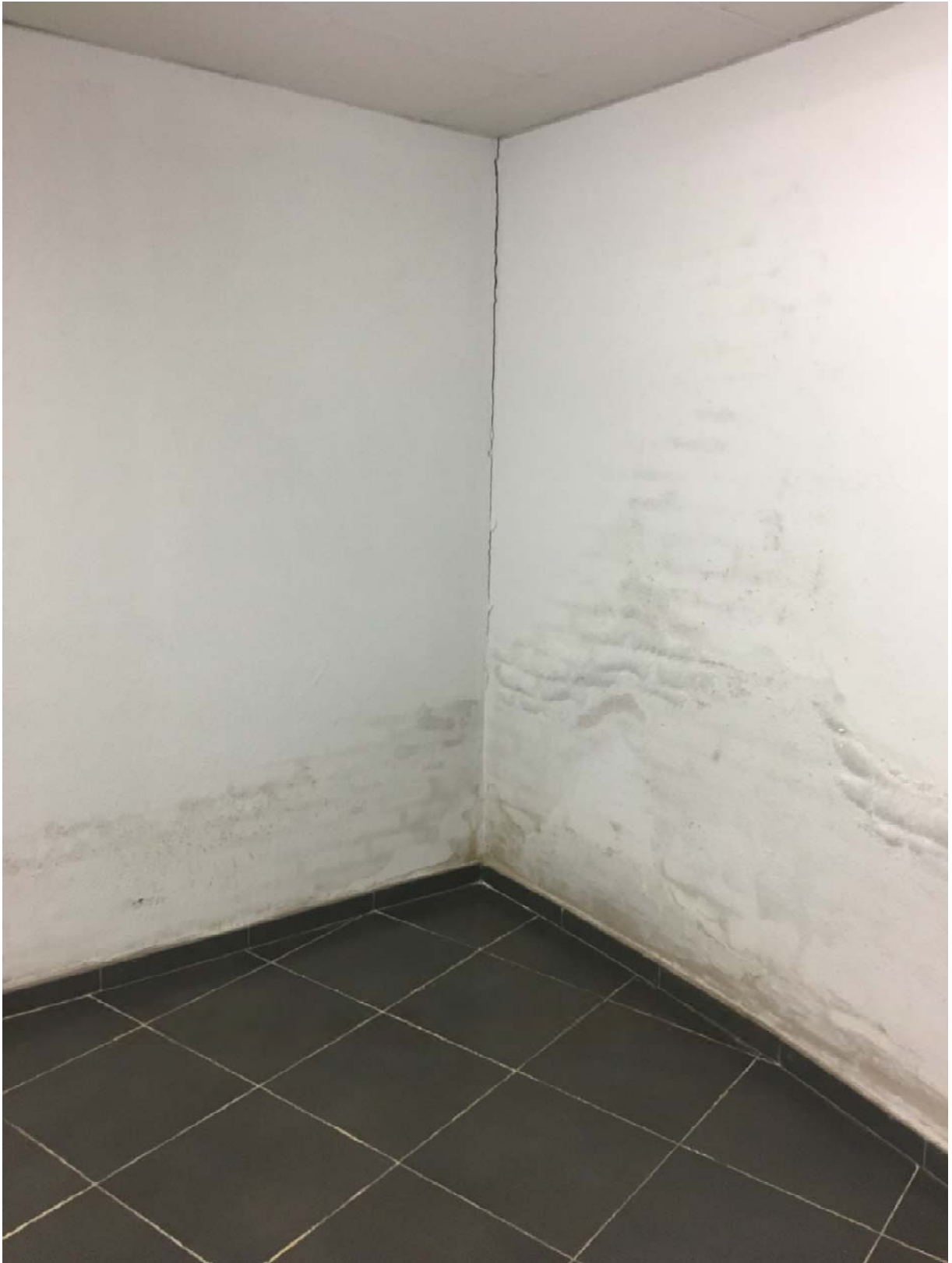
ZONA 4_3 – CUARTO ALMACENAJE CAFETERIA.
