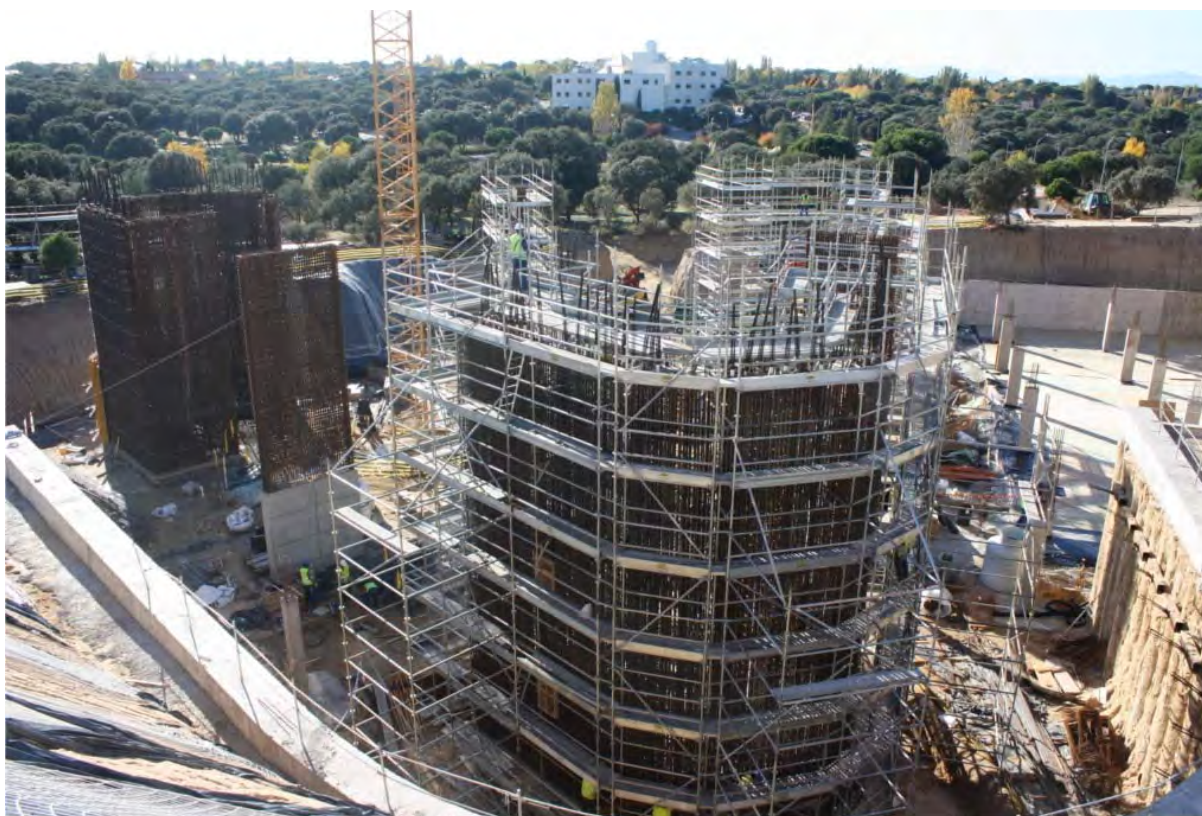
VISTA CIMENTACION Y ESTRUCTURA EN EJECUCION OTOÑO 2010
