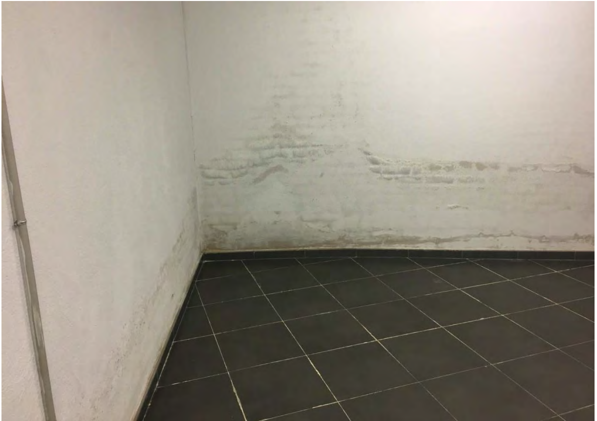
ZONA 4_1 – CUARTO ALMACENAJE CAFETERIA.
