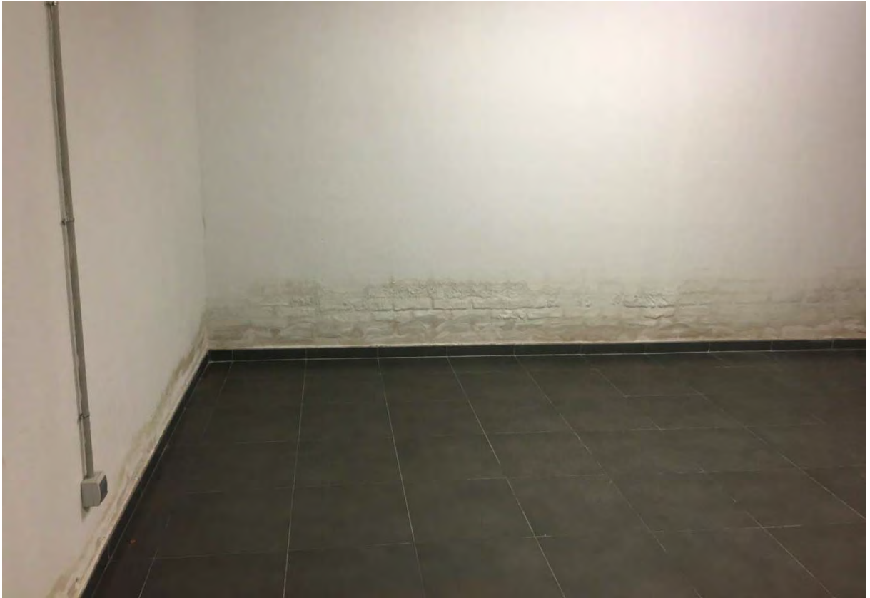
ZONA 3_1 – CUARTO ALMACENAJE.
