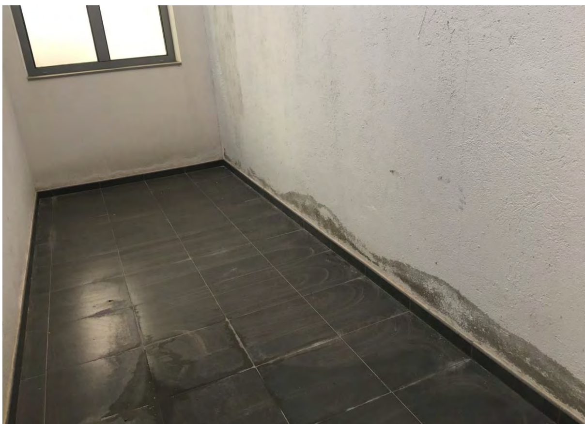
ZONA 6_1 – PATIO COCINA E INSTALACIONES.
