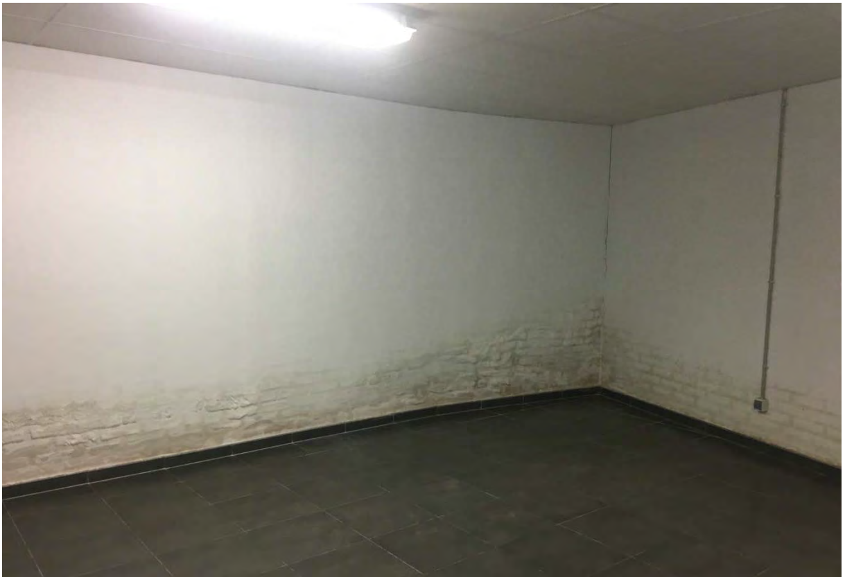
ZONA 3_2 – CUARTO ALMACENAJE.
