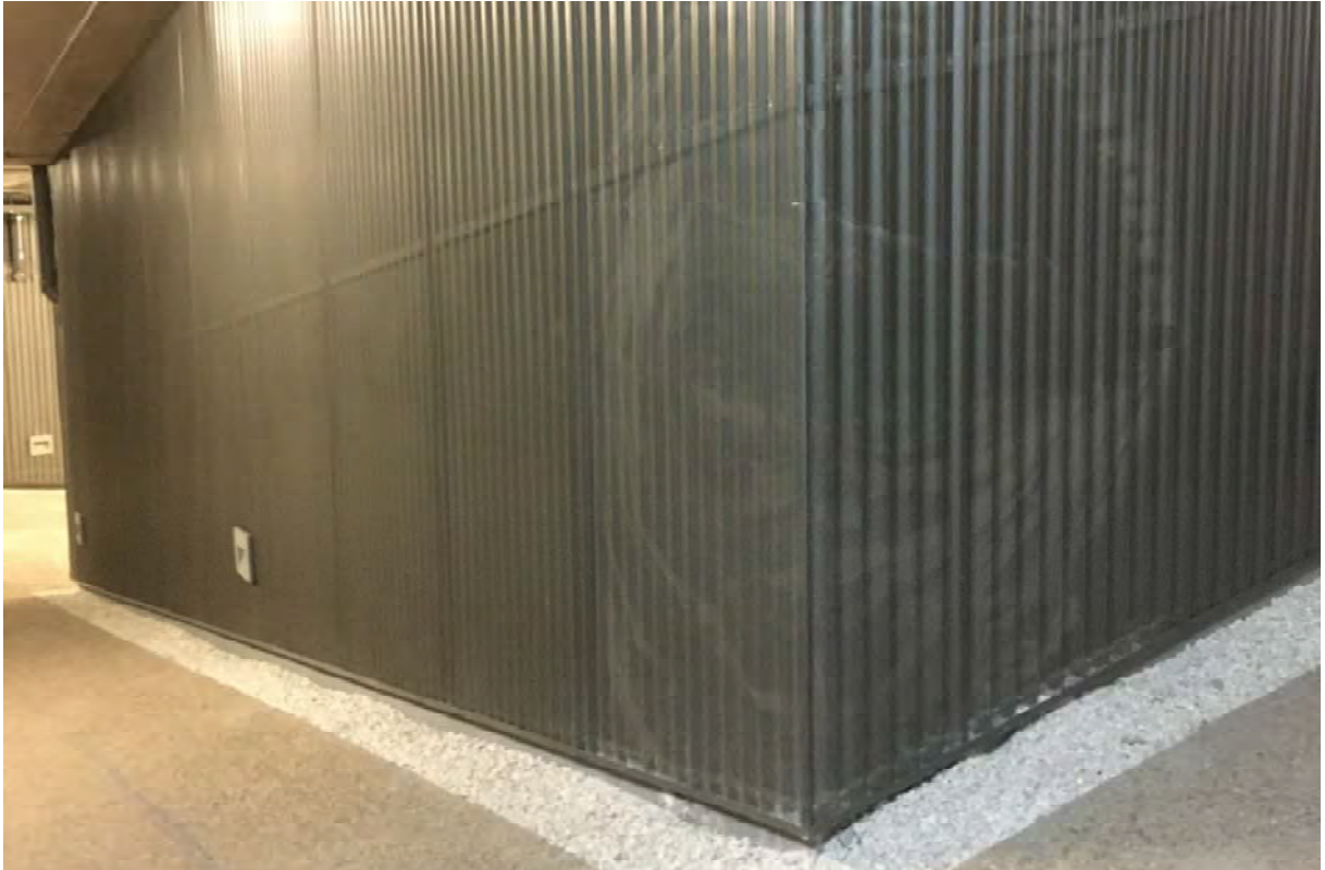
VISTA REVESTIMIENTO DE CHAPA PERFORADA EN MUROS DE ACCESO GARAJE.
